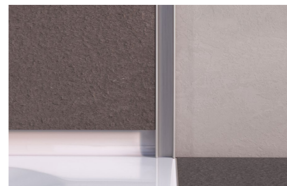
U-Profil wird von den Fliesen eingefasst
